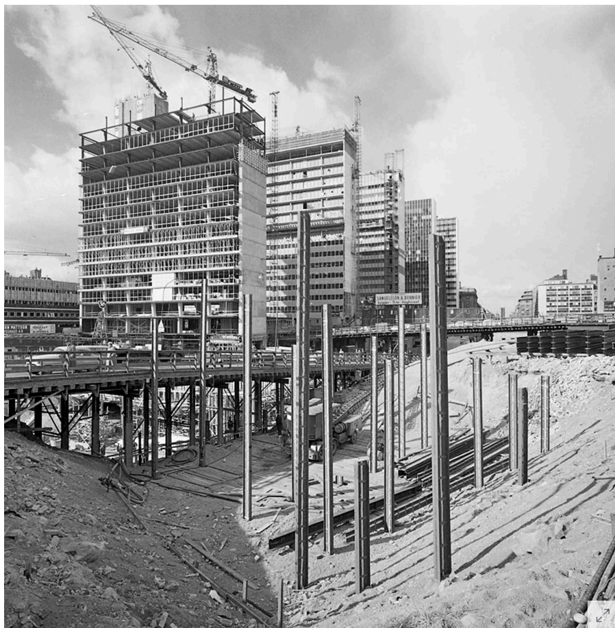
Riksgropen på Norrmalm i Stockholm 1963. Hötorgsskraporna under uppbyggnad. Foto: Lennart av Petersens
